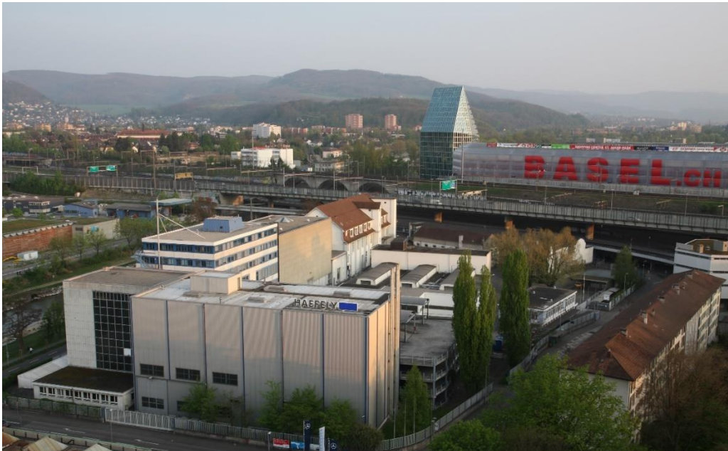
Blick auf das Haefely-Areal (Foto Haefely AG)
